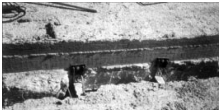
Refuerzo de viguetas debido a su descuelgue
